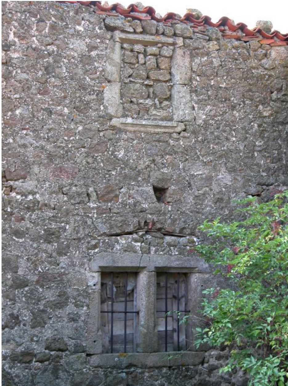
Détail de baies de la façade arrière de l'aile nord du château.
