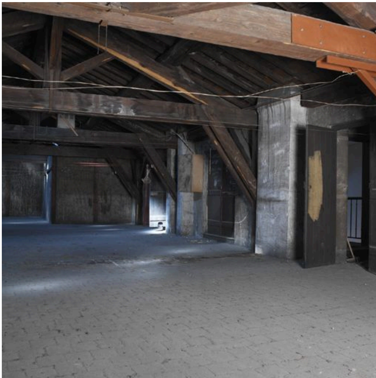
La charpente du corps de bâtiment sud, côté nord
