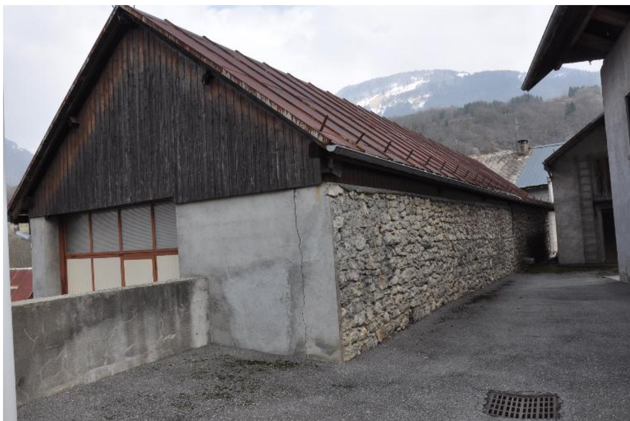
Vue arrière du bâtiment situé à l'emplacement de l'ancienne scierie.
