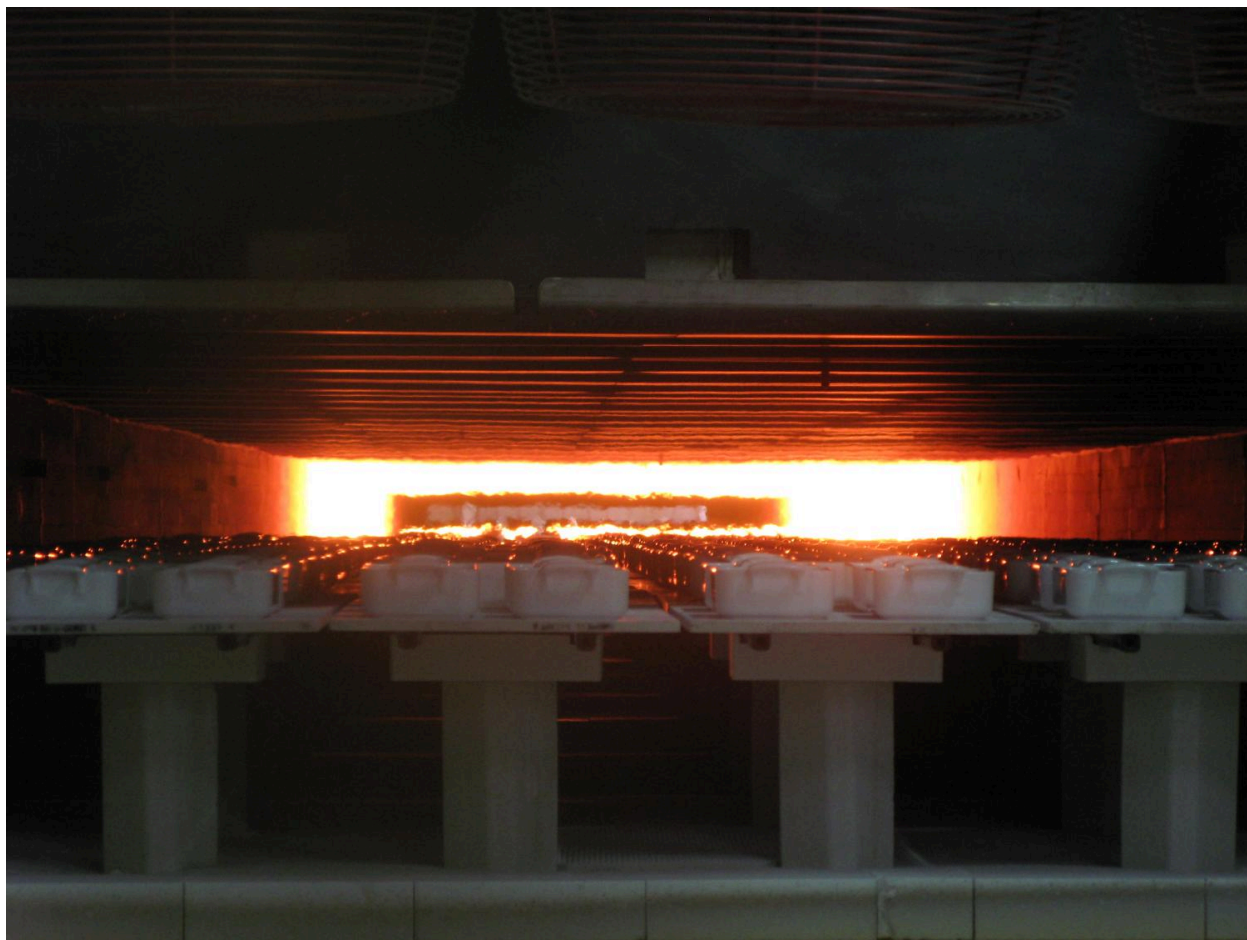
Cuisson, vue du four tunnel.
