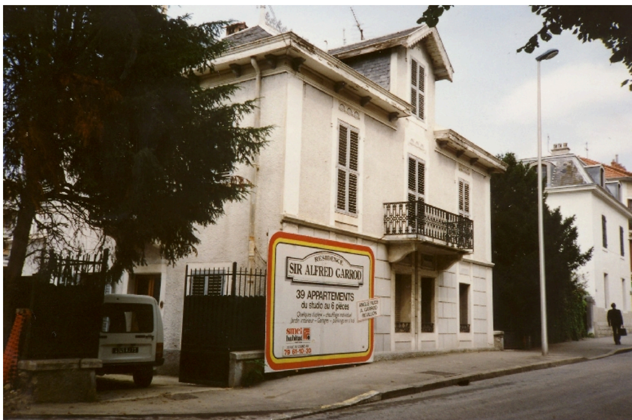
Vue d'ensemble, avant démolition
