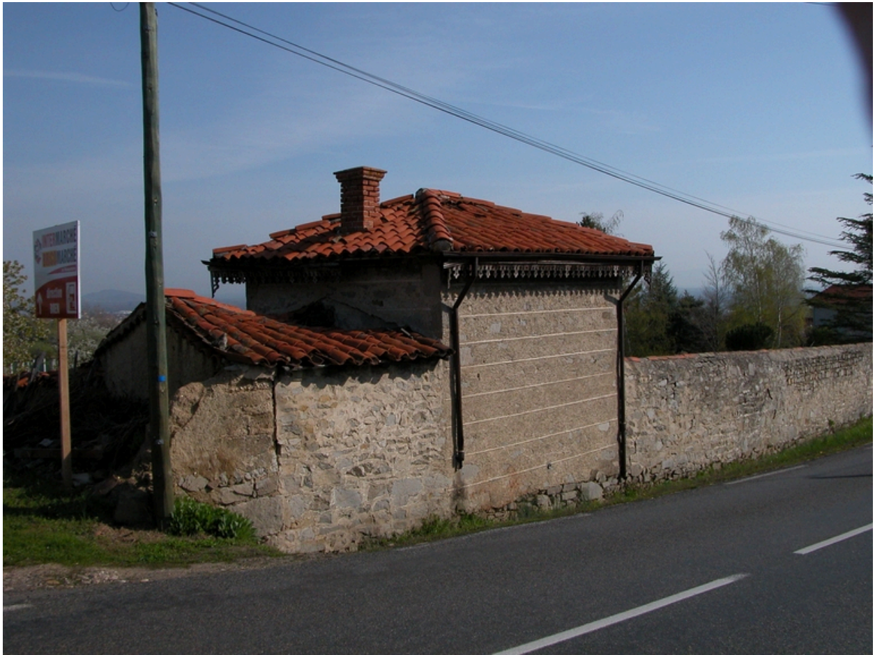
Vue d'ensemble de l'élévation postérieure, depuis le chemin.
