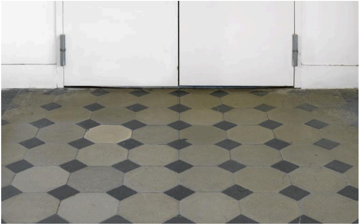
Corps de bâtiment sud, 2e palier de l'escalier principal : dallage en pierre
