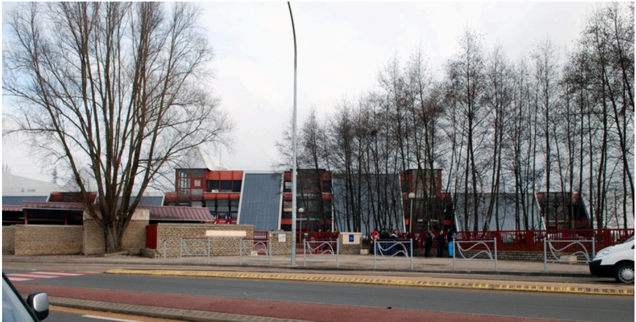
Bâtiment A. Vue partielle depuis le sud-est
