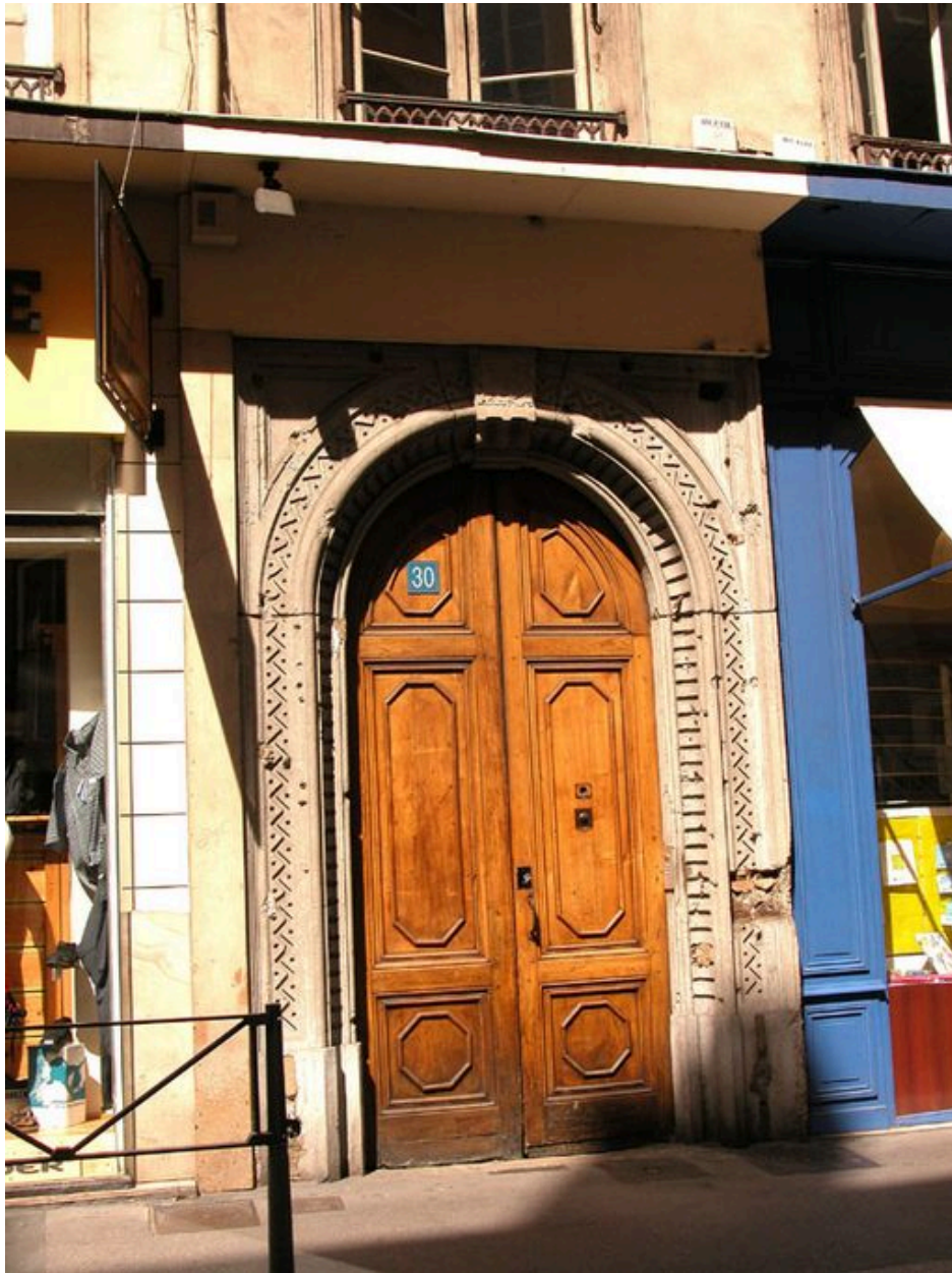
Détail de la porte : vue extérieure
