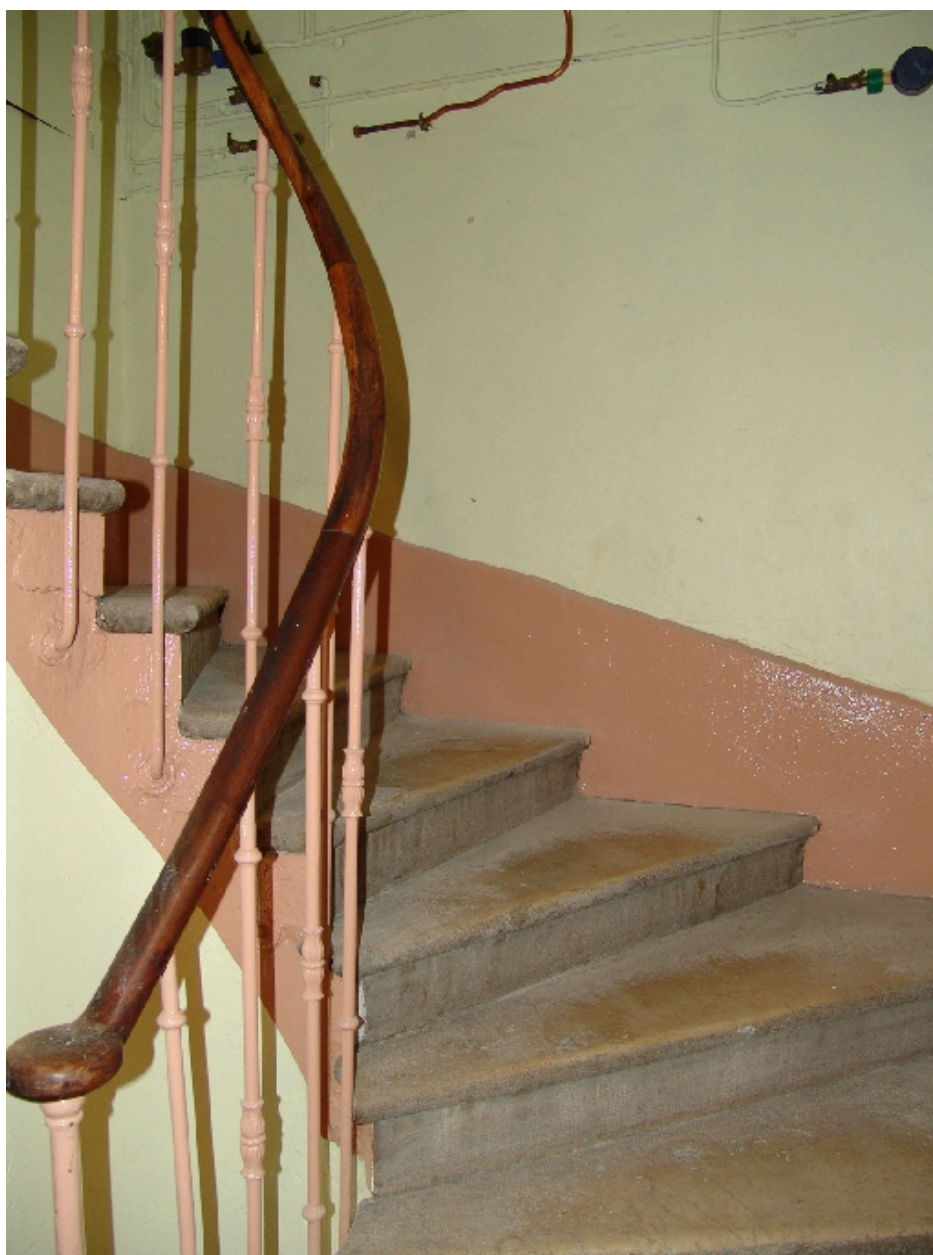
Détail de l'escalier
