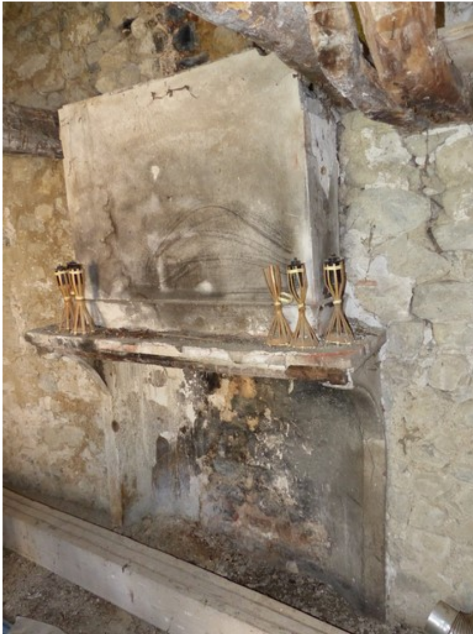
Dépendance sud-ouest. Rez-de-chaussée surélevé, logement. Mur ouest, cheminée.
