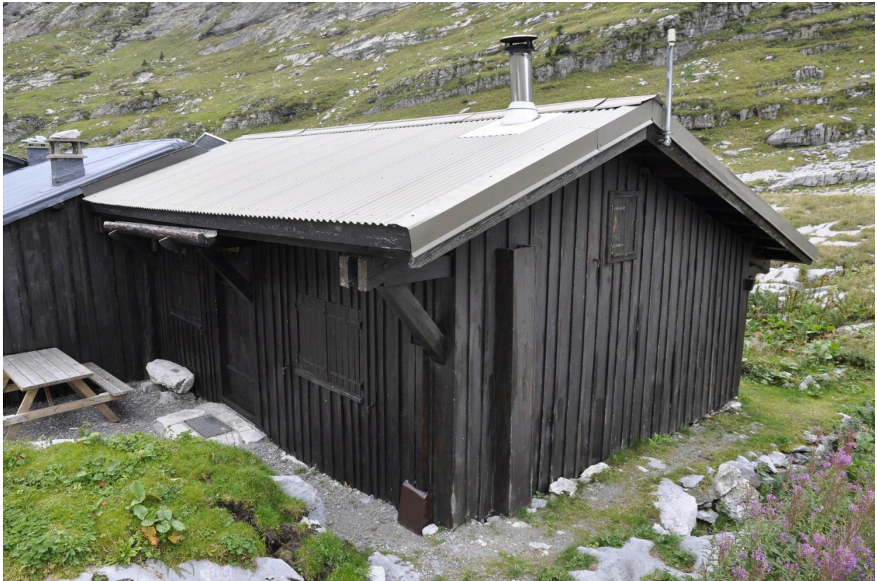
Vue de l'élévation nord-est
