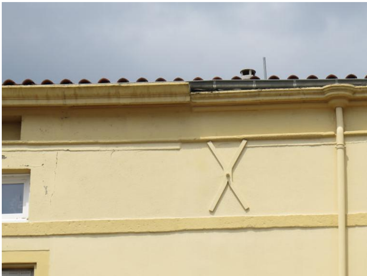
Vue de détail : corniche moulurée avec évacuation en cuvette
