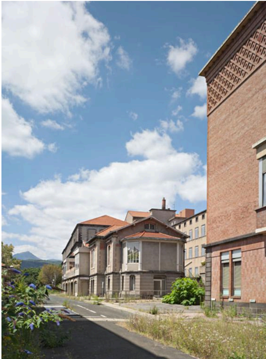
Hôtel-Dieu de Clermont-Ferrand. Vue générale depuis l'entrée orientale (avenue Vercingétorix).
