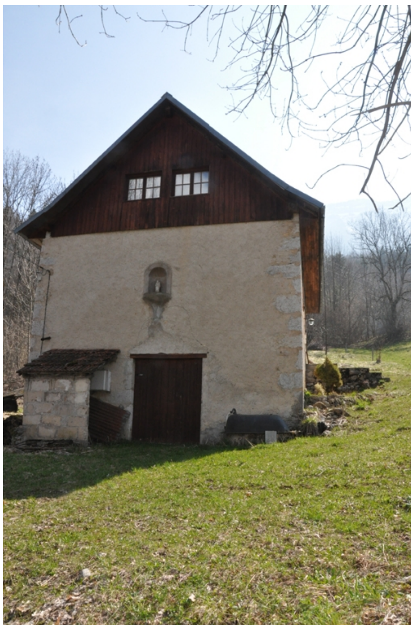
Vue de la façade ouest
