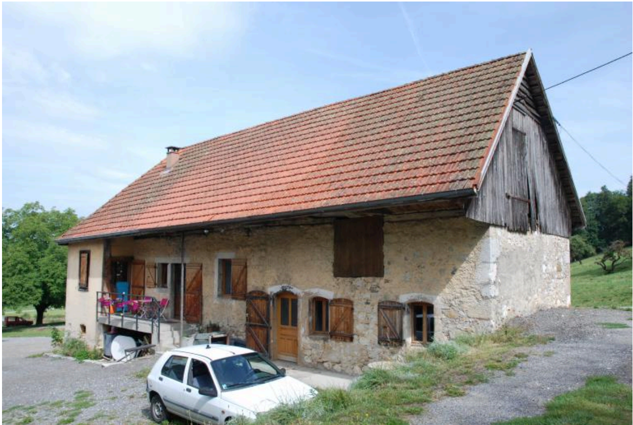
Vue d'ensemble de trois-quarts avant droit du logis de la ferme.
