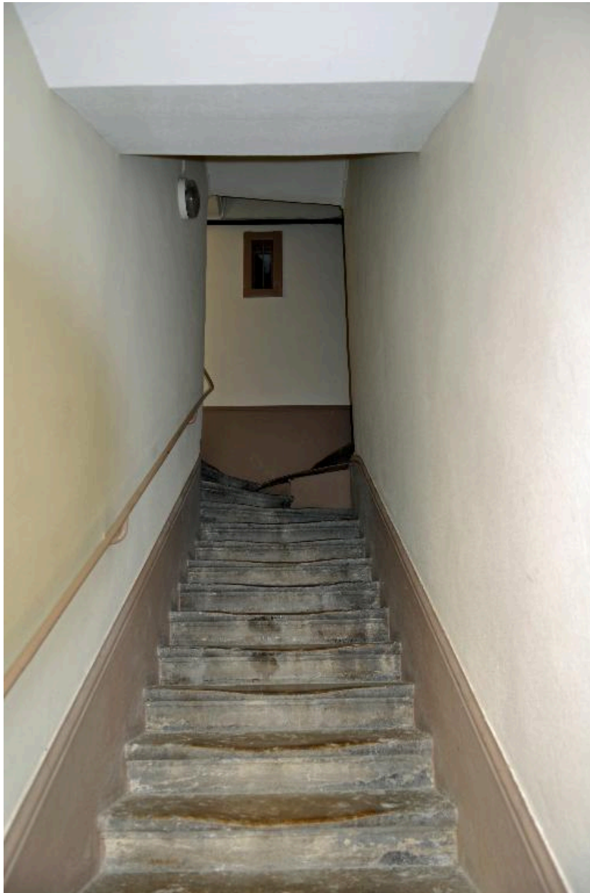
Immeuble sur rue, vue de la première volée d'escalier décalée à droite du passage cocher
