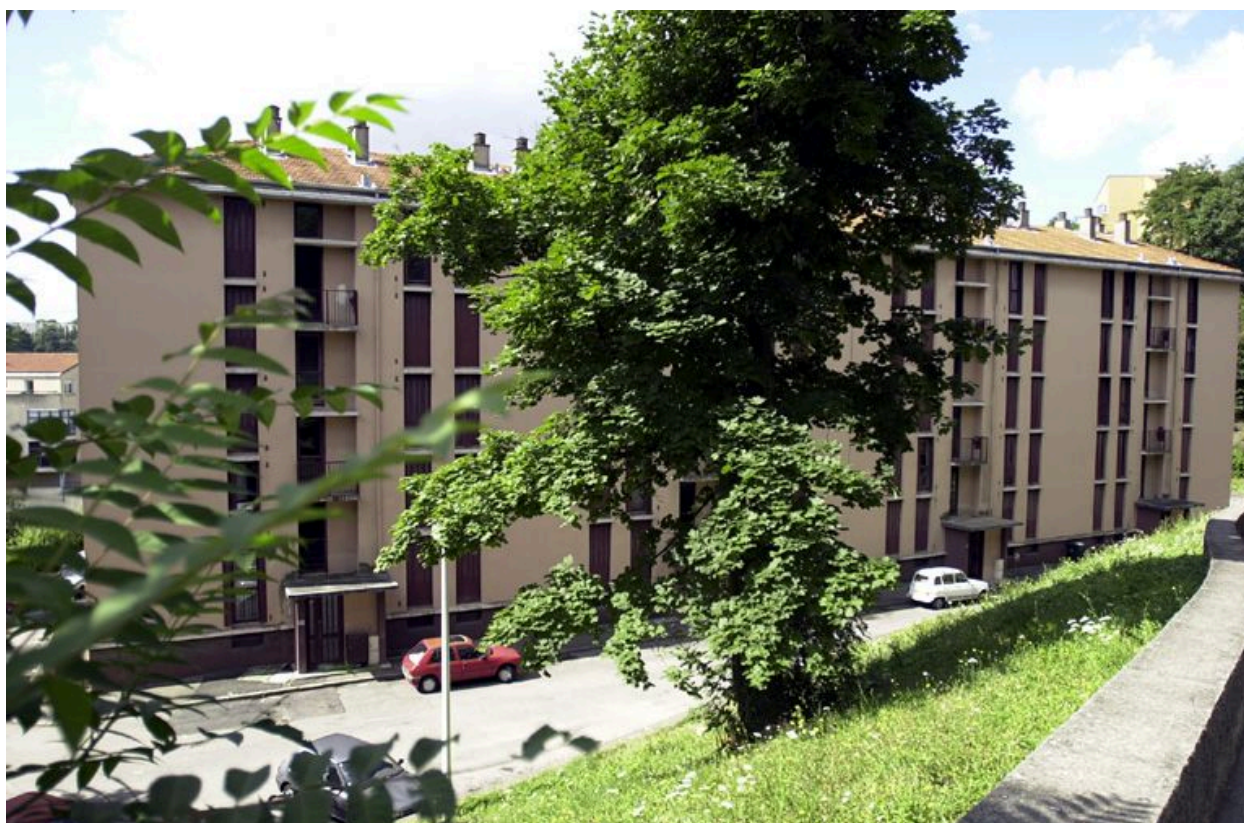
Elévation antérieure du bâtiment 9, 2-8 rue Simondan
