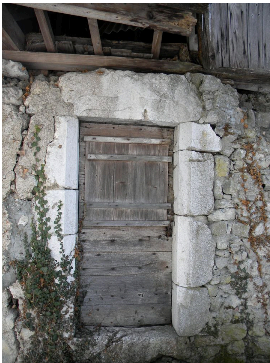
Porte avec accolade en façade arrière.
