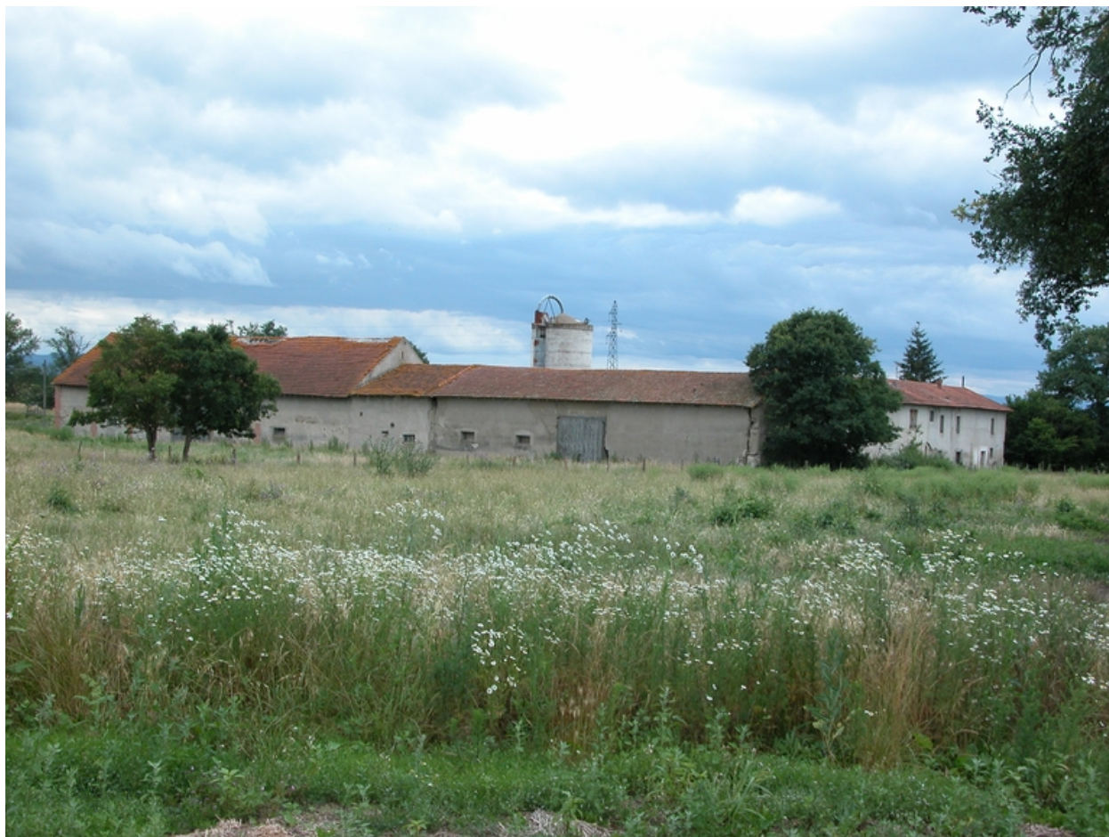
Vue générale de l'angle nord-ouest, depuis le nord-ouest.
