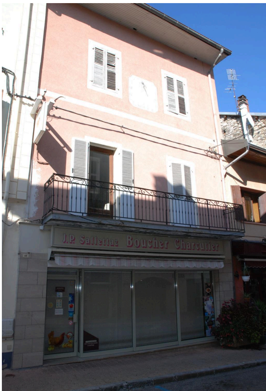
Maison, immeuble (en 1890 et 2018 : boucherie), 60 rue Louis Blanc-Pinget (2018 E1 343). Elévation sur rue.
