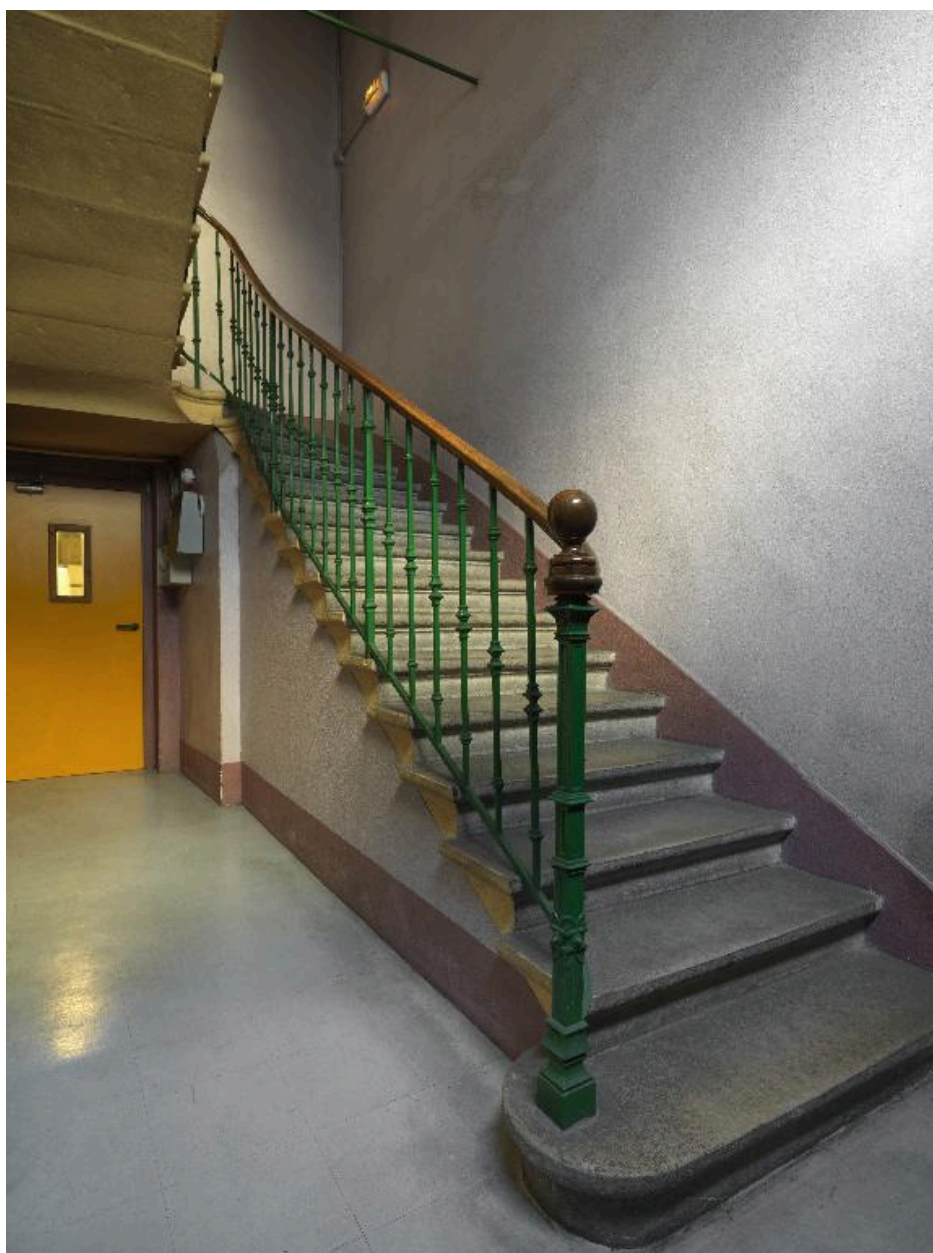
Escalier angle Créqui-Servient, vue est, r-d-ch.
