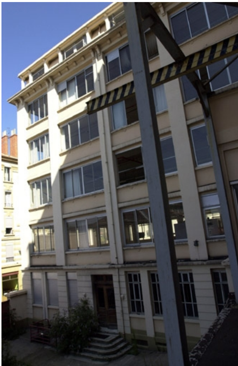
Façade sud du bâtiment des années 20
