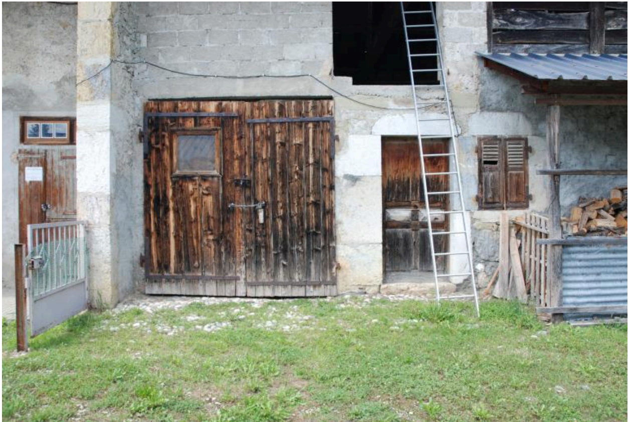
Vue de l'habitation est.
