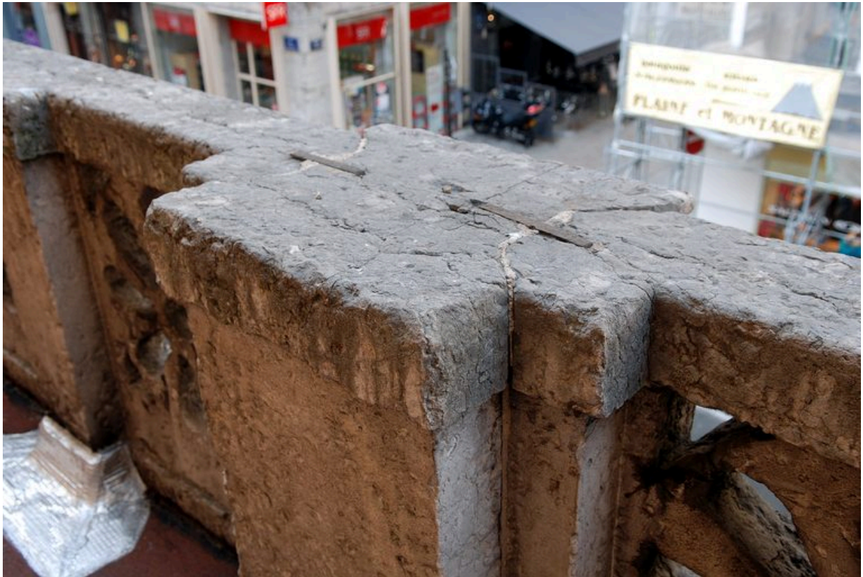
Elévation ouest : garde-corps de la terrasse
