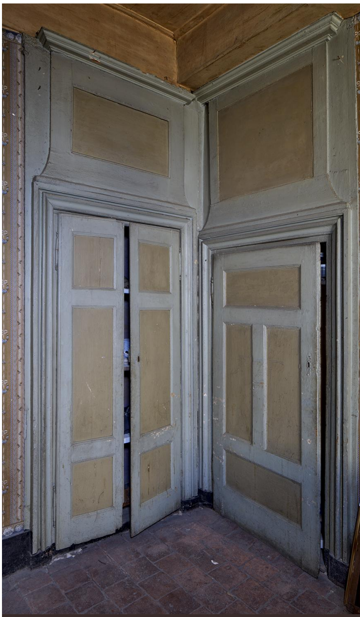
Etage carré, chambre 2, vue d'ensemble des deux placards muraux.
