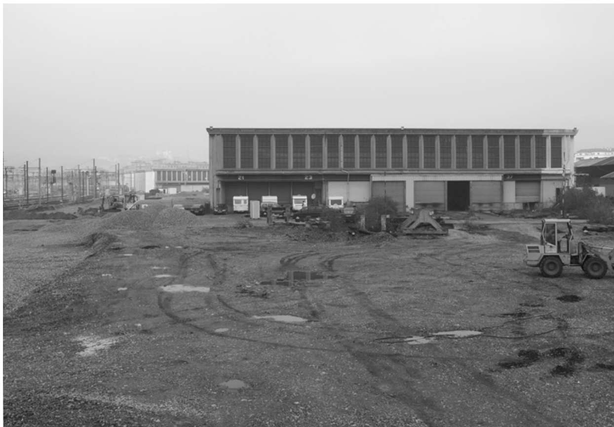
Partie est du site
