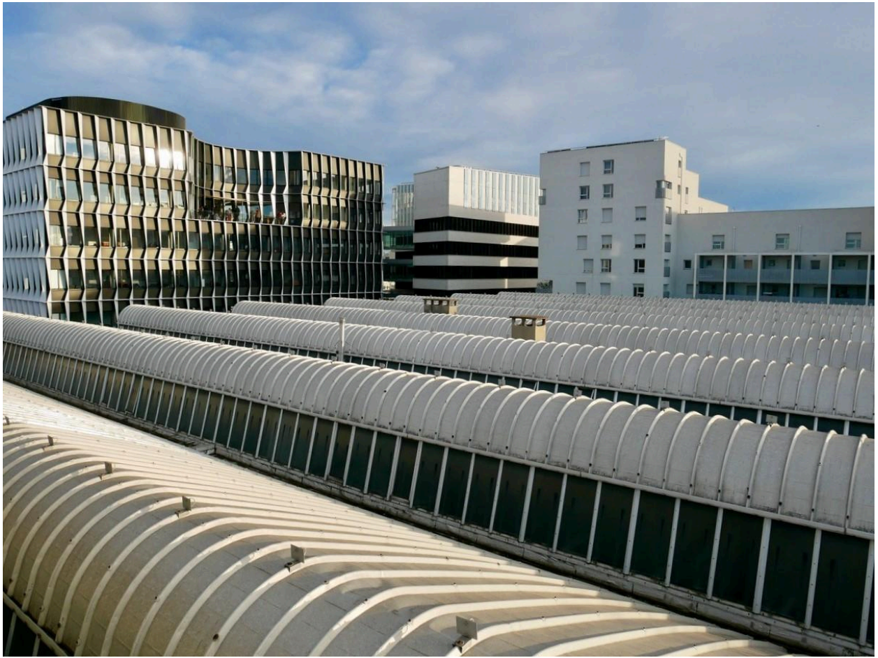
Vue extérieur des toitures shed
