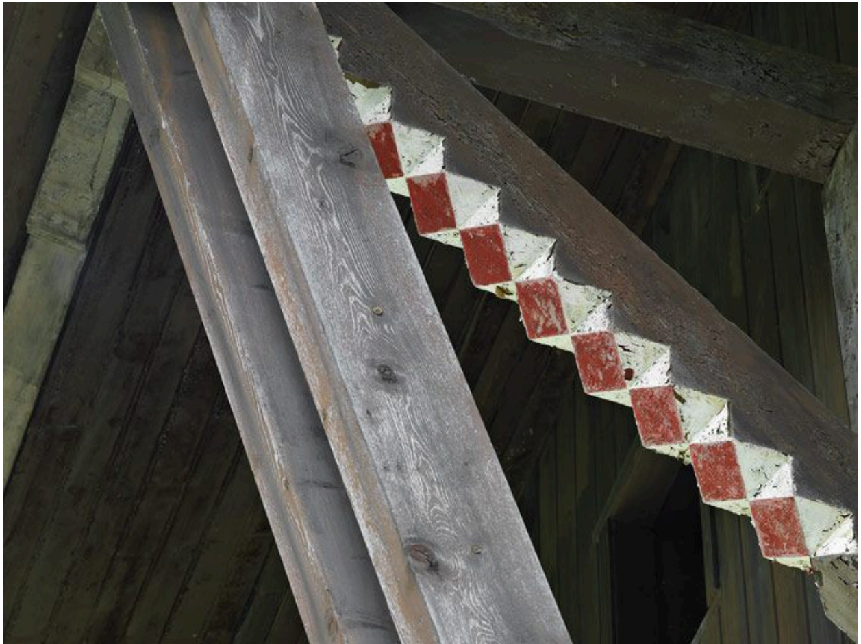
Angle sud-ouest. Détail des supports d'avant-toit
