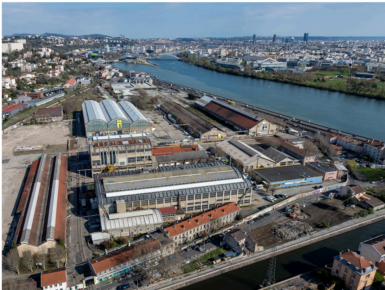
Ateliers SNCF de la Mulatière (drone), vue sud
