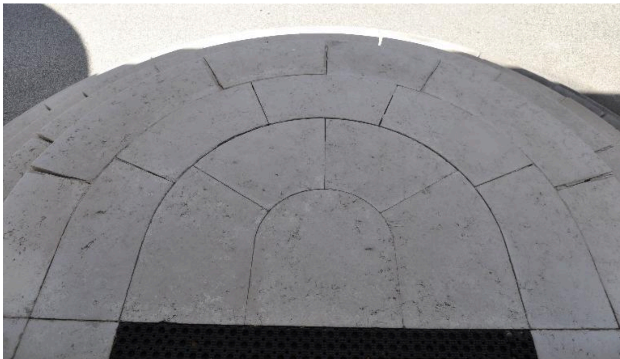
Détail de l'emmarchement
