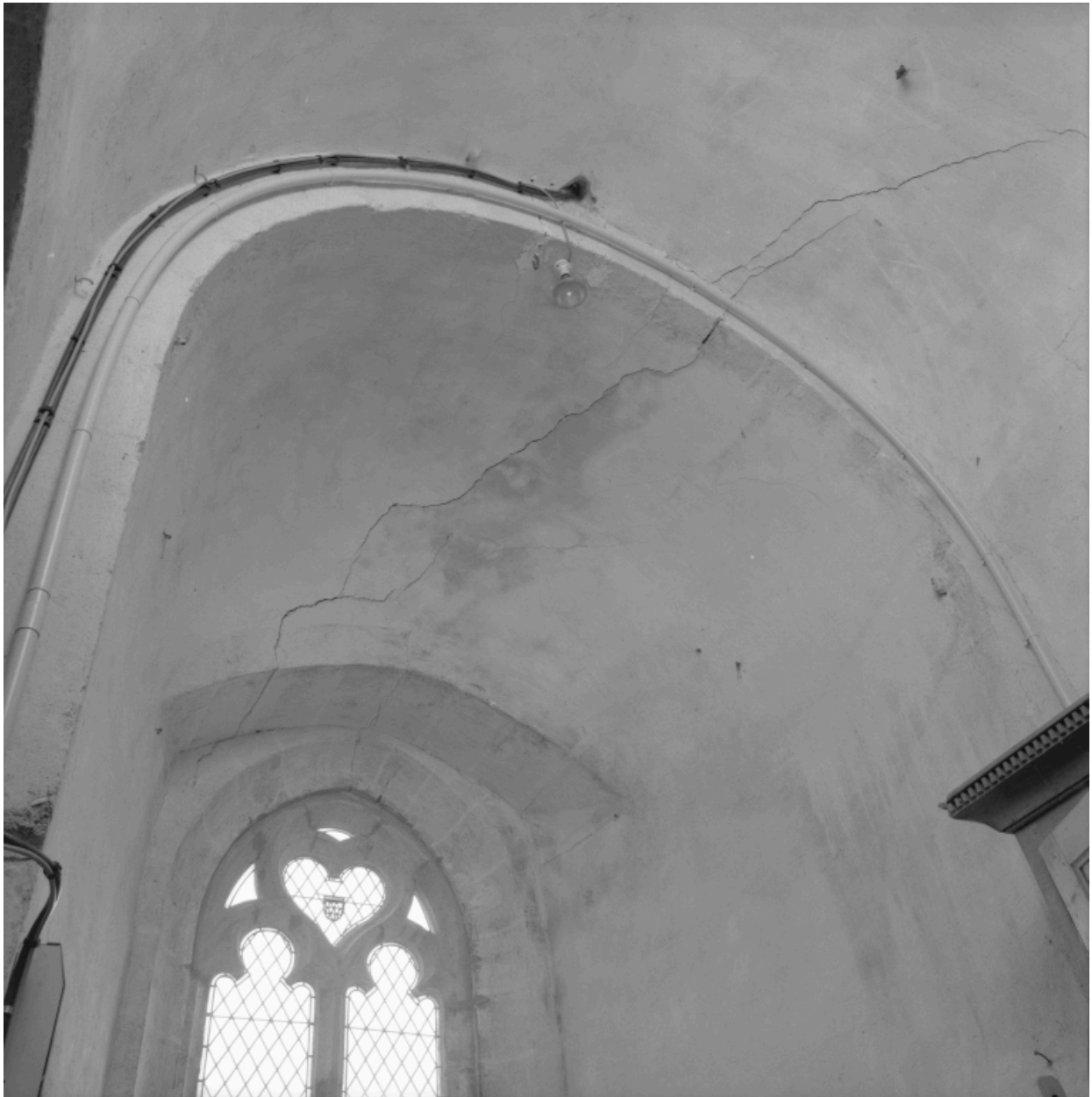
Absidiole sud, cul-de-four.
