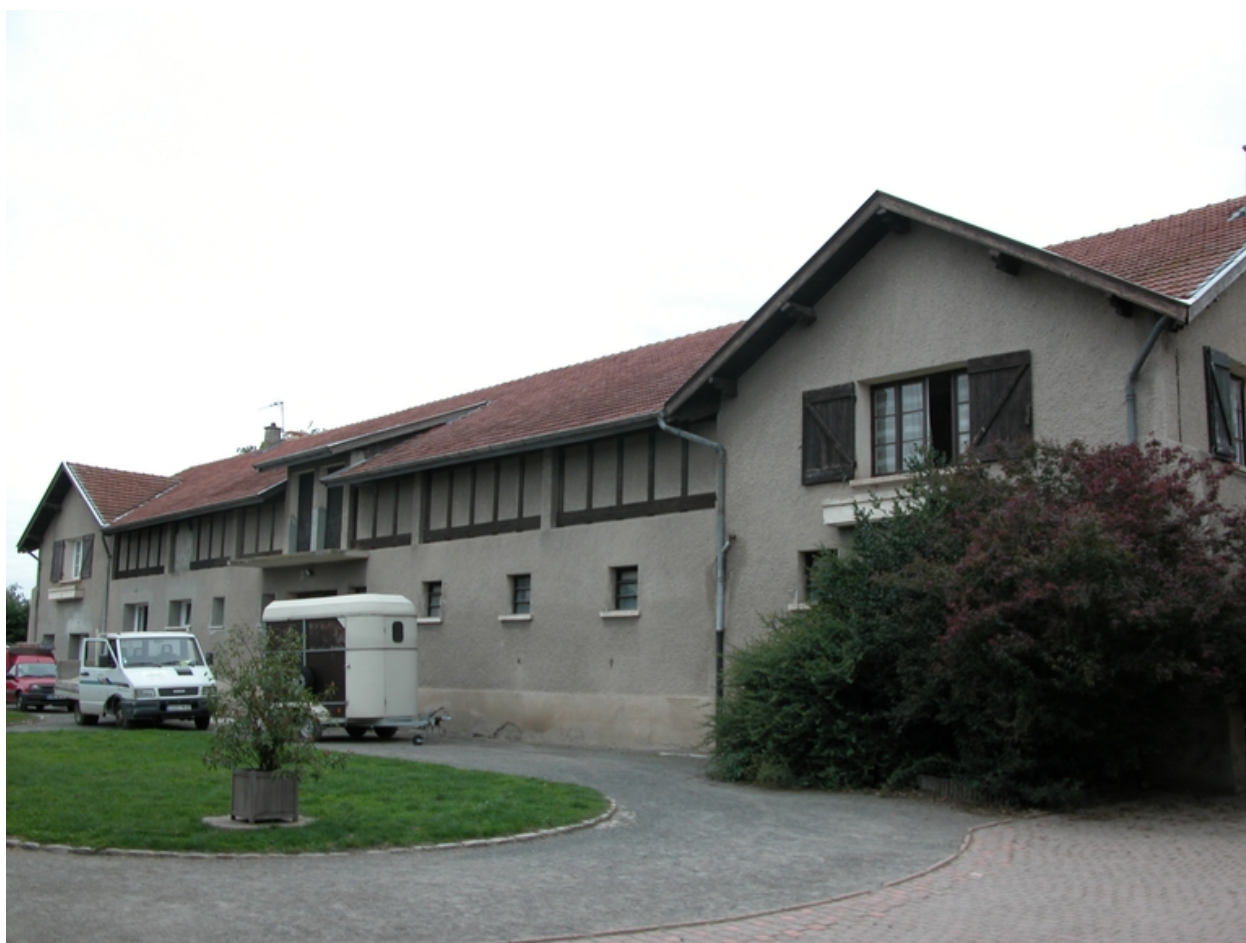
Vue du bâtiment sud-ouest depuis la cour.
