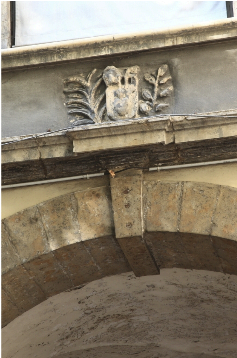
Ecu (armorié ?) sur la façade occidentale de la cour.
