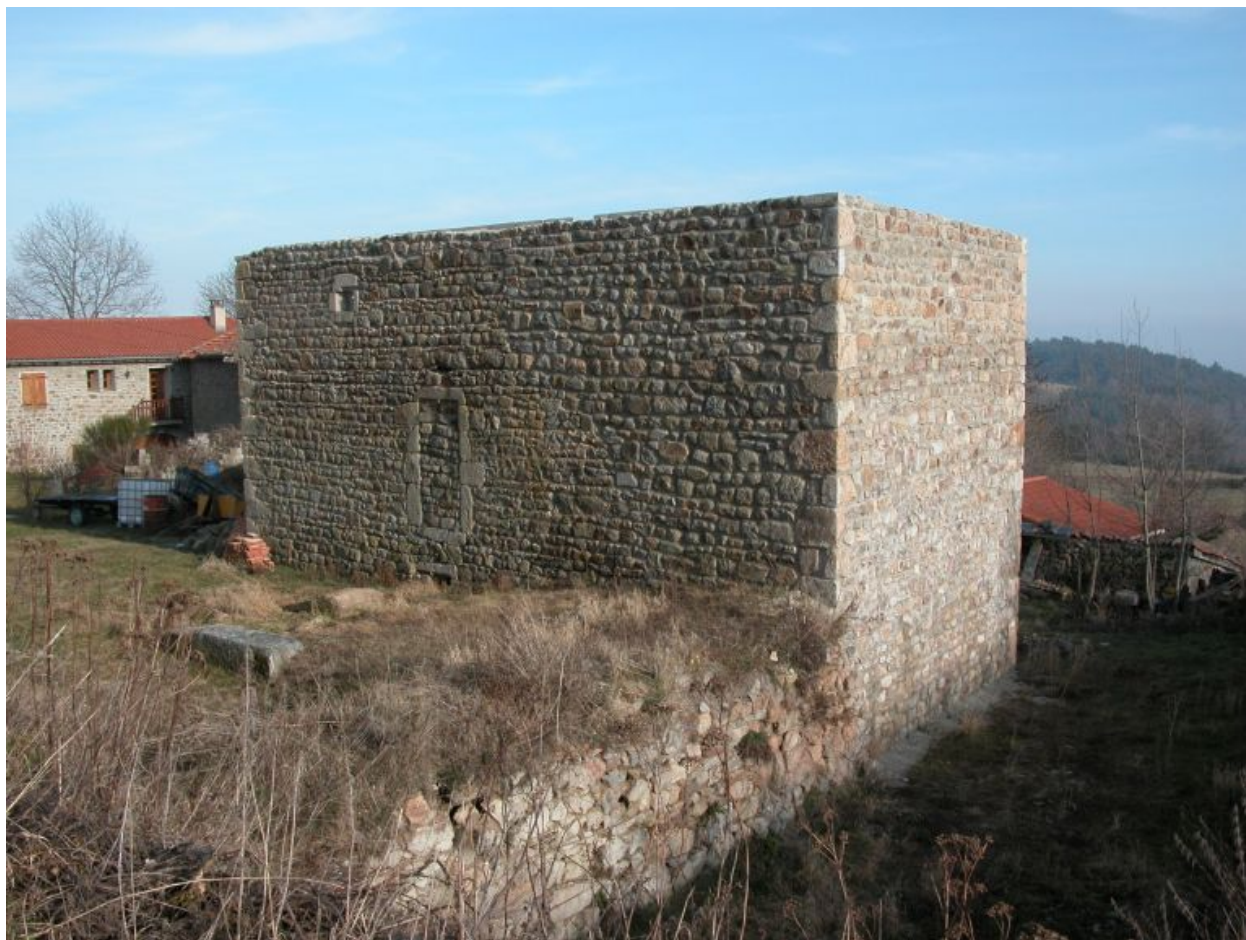
Vue générale du bâtiment, de trois-quarts arrière gauche.
