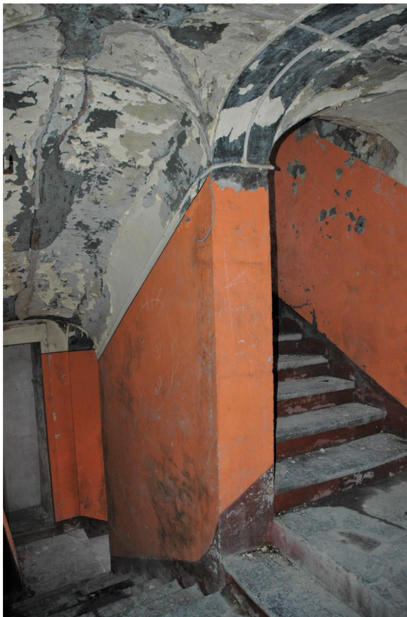
Vue intérieure de l'escalier entre le 1er et le 2e étage.
