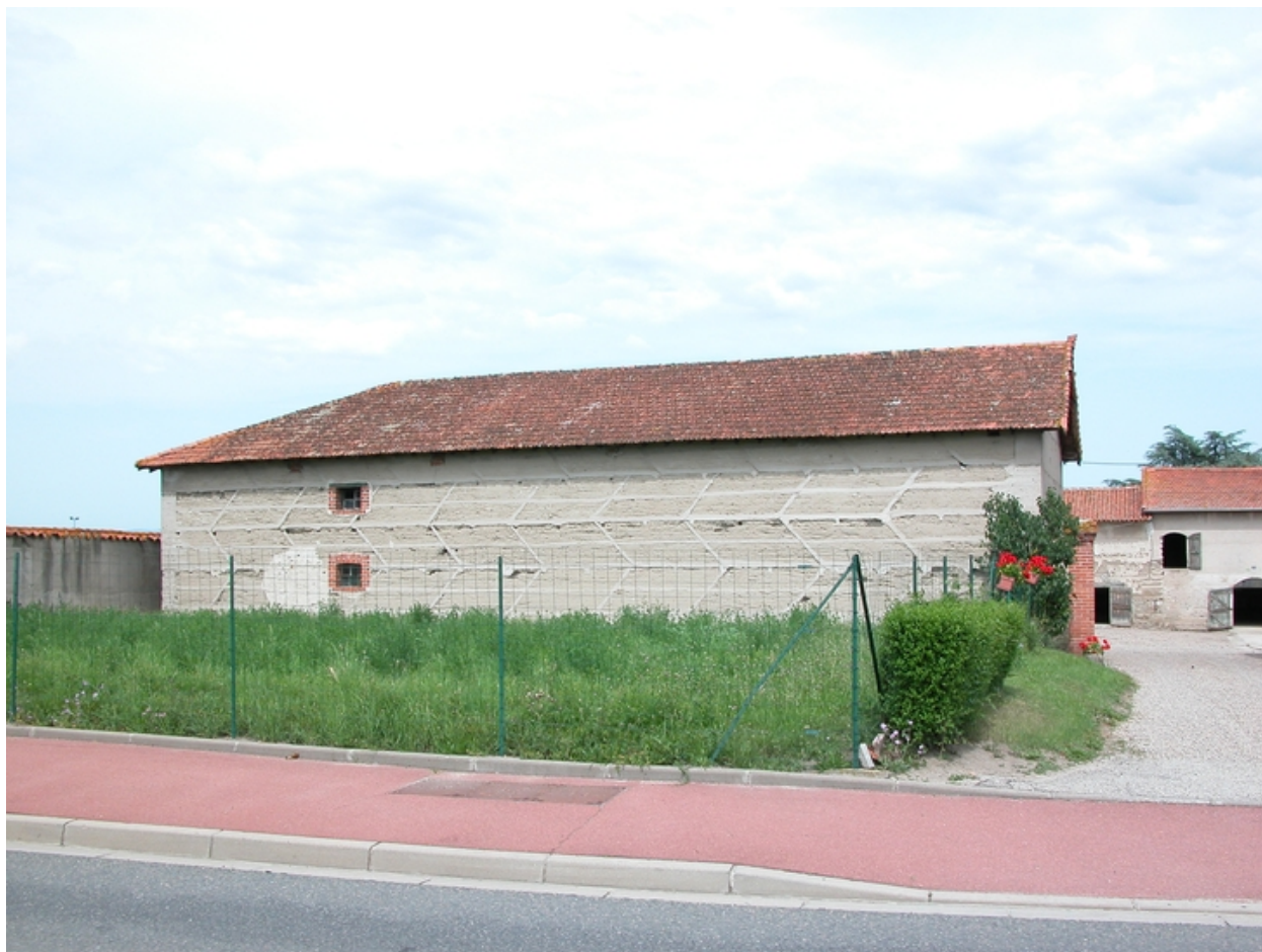
Vue d'ensemble du hangar, depuis l'ouest.
