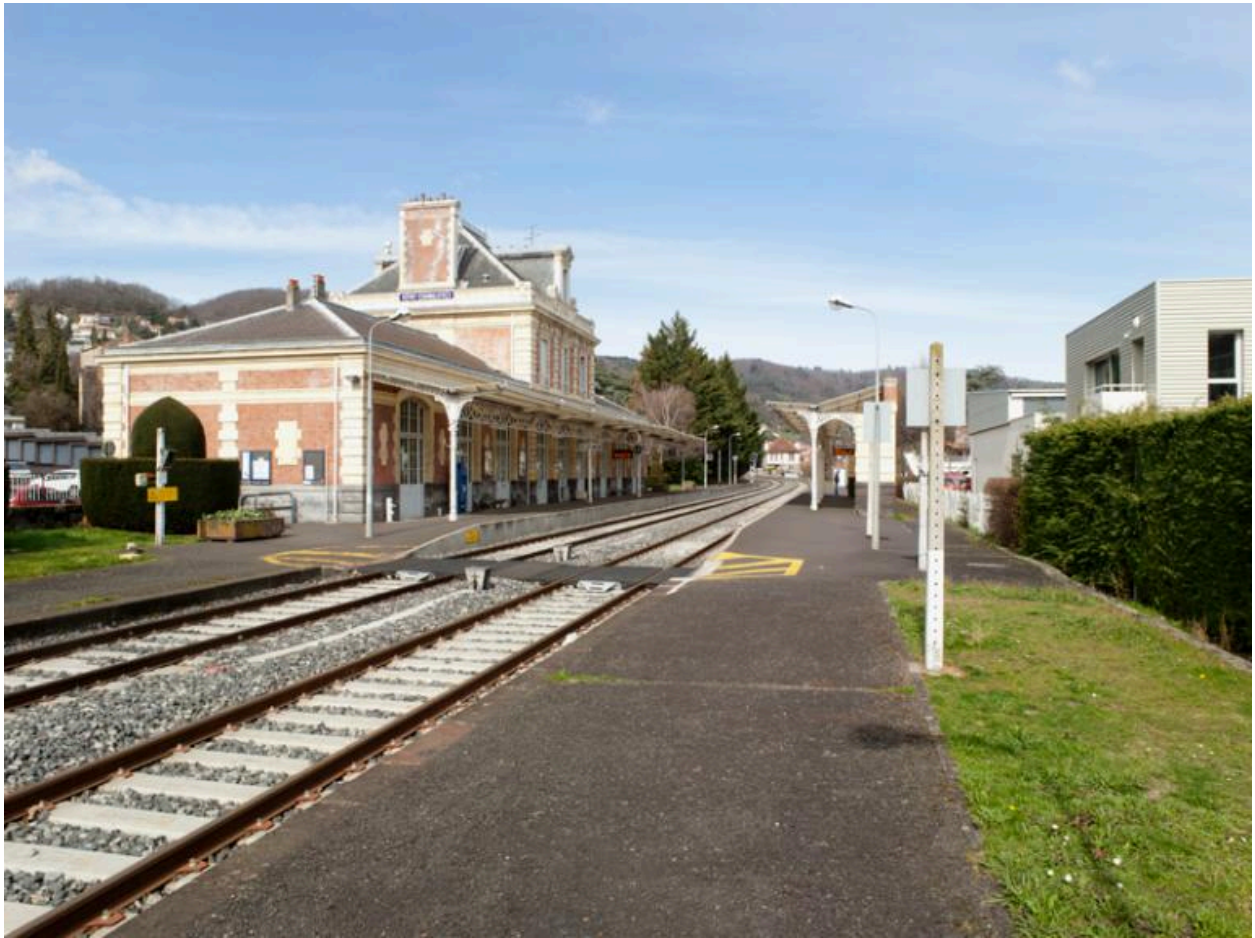
Vue générale de la gare de Royat-Chamalières, côté voies.
