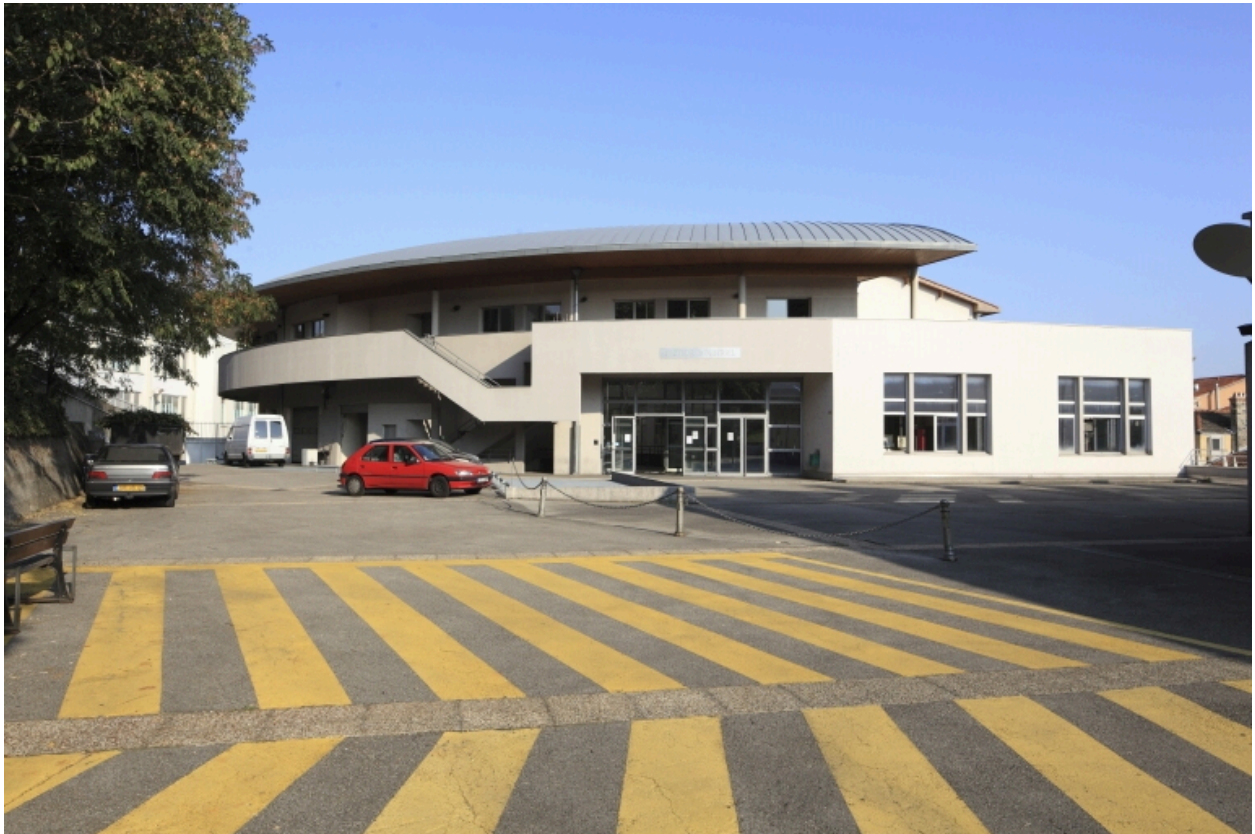
Côté sud, terrasse supérieure, entrée supérieure du bâtiment de l'enseignement technique.
