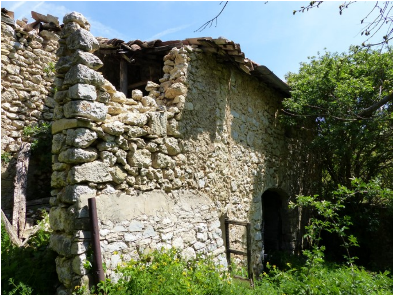
Ensemble oriental. Partie sud. Elévation ouest, partie sud.
