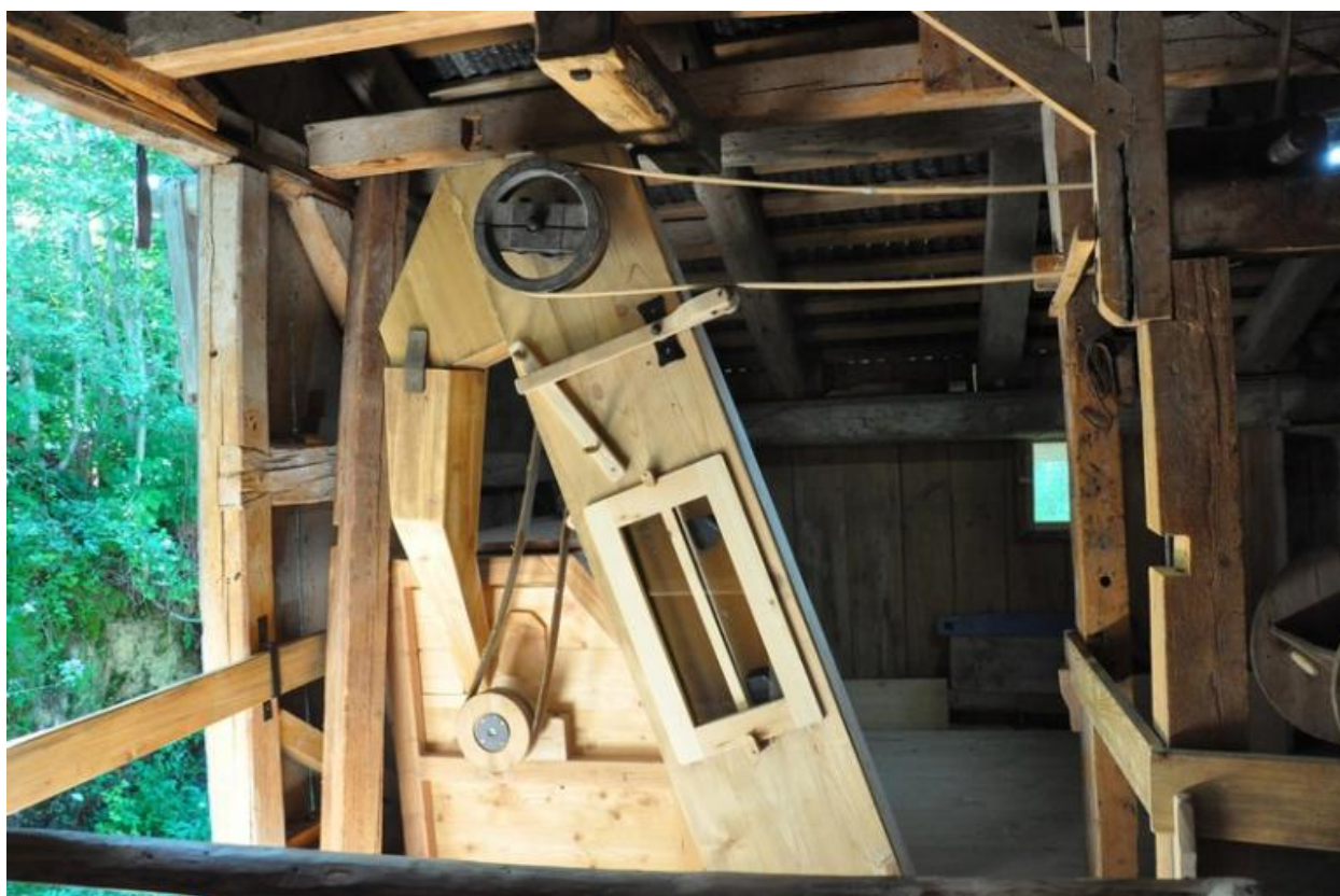
Elevateur à godets restauré.
