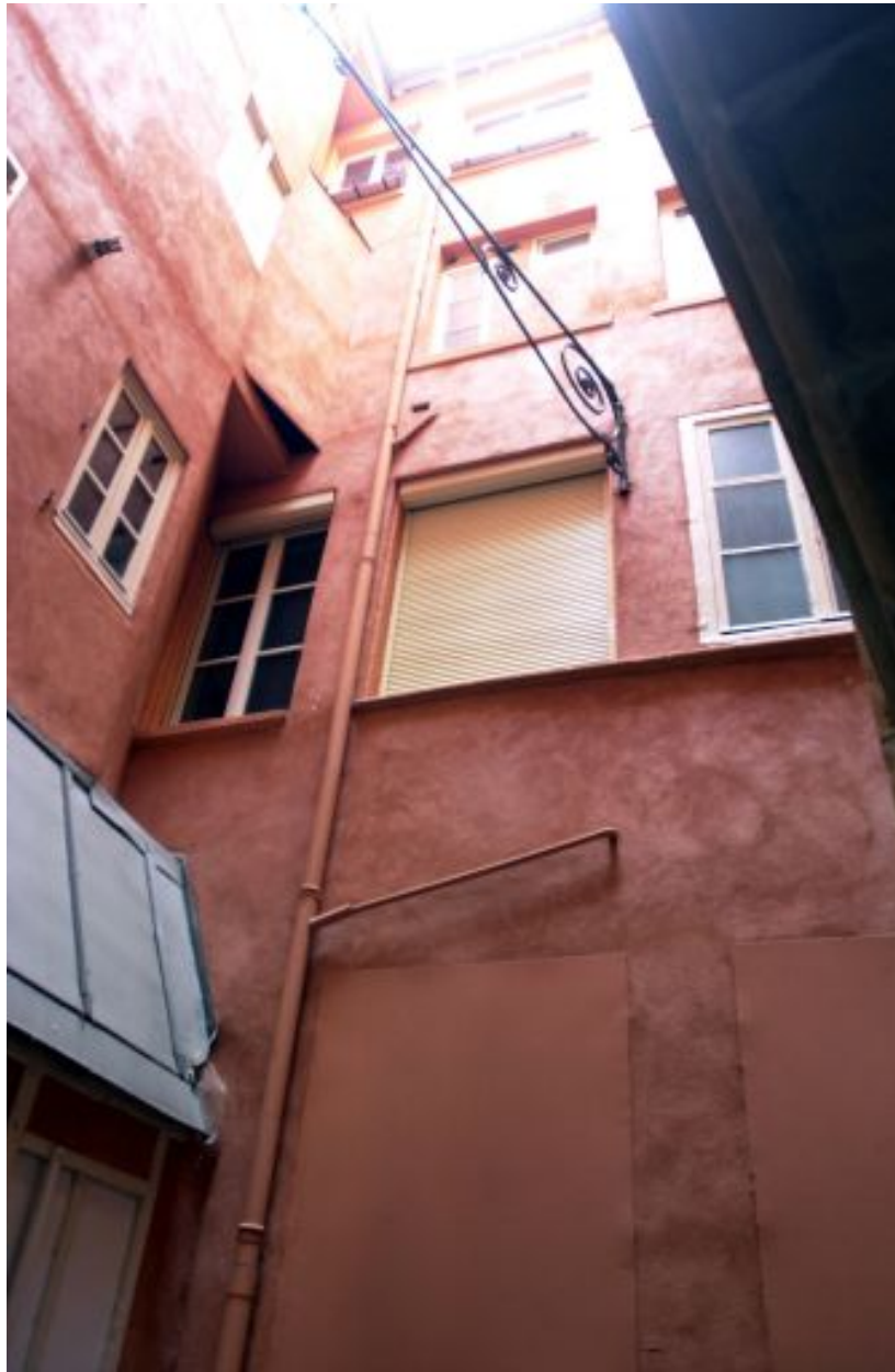
Cour I, élévation du bâtiment 2
