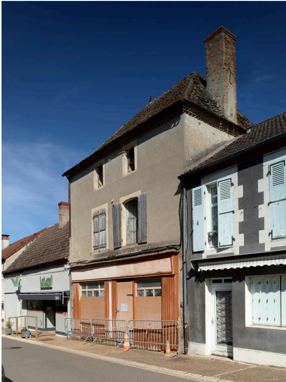
Maison dite hôtel des Vilhardin de Marcellange, 8, rue Monnet parcelle cadastrale B01 : 94.
