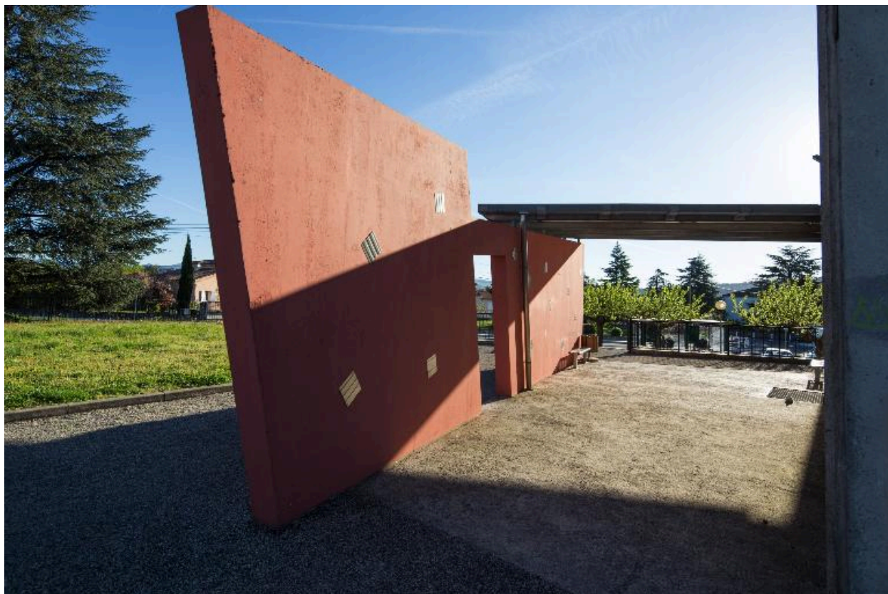
Bâtiment nord : pignon nord, auvent.
