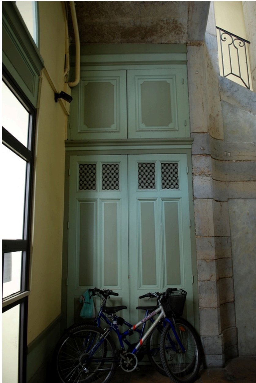
Escalier : boiseries au rez-de-chaussée
