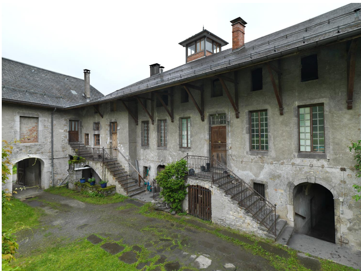
Vue des bâtiments depuis de la cour, du nord-ouest.
