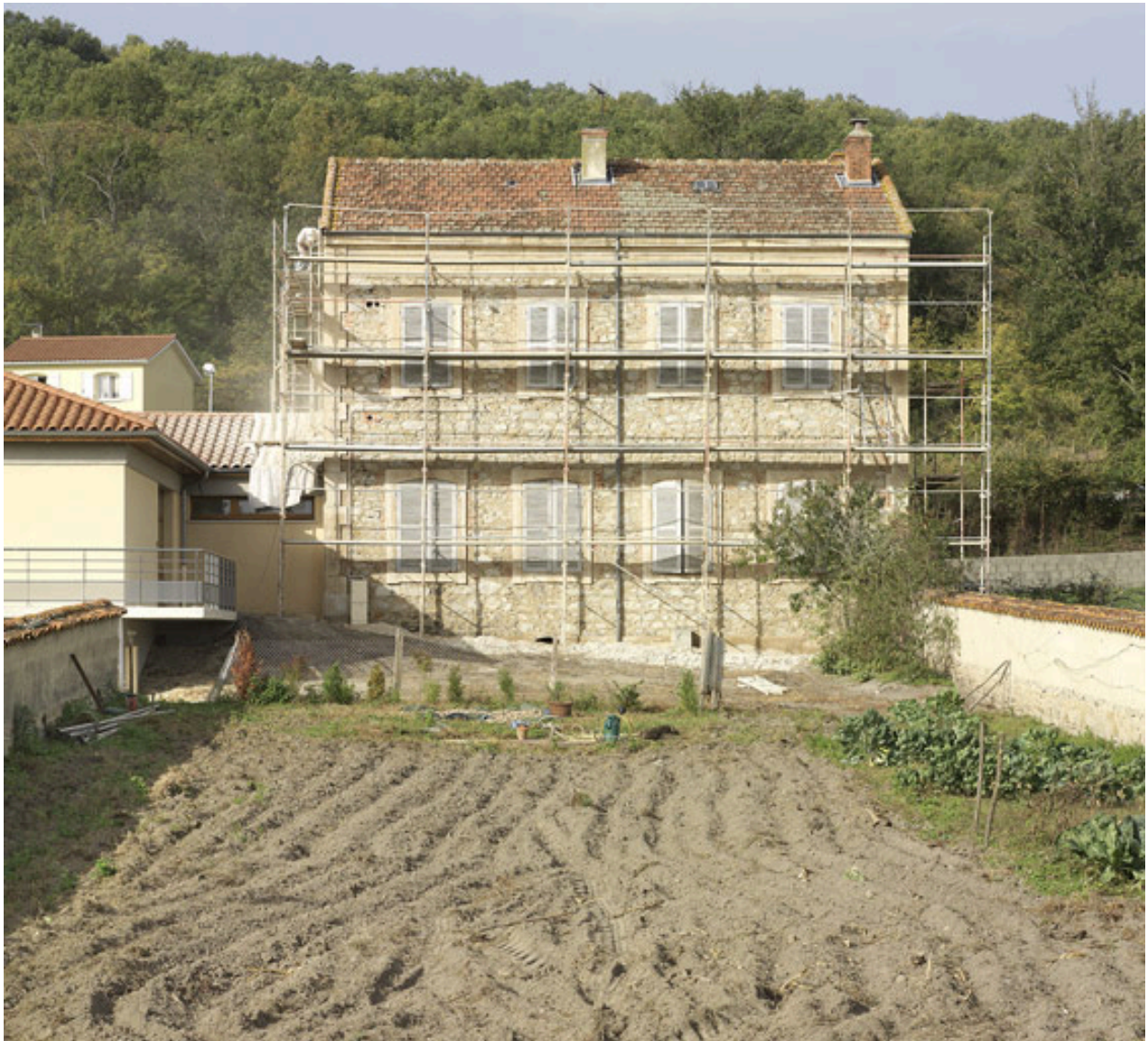
Vue de la façade sur jardin, en travaux.
