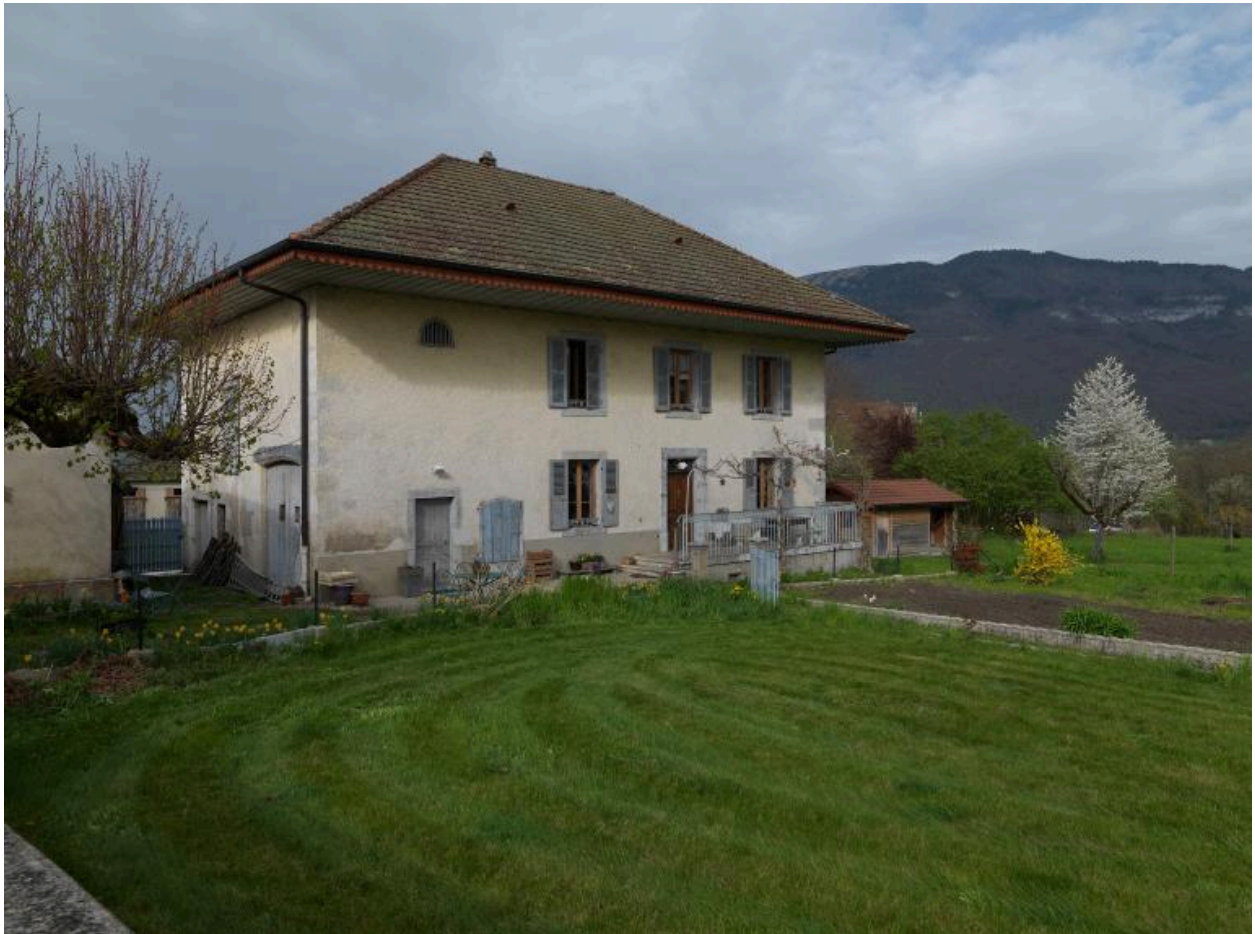
Vue d'ensemble de trois-quarts avant droit de la maison.
