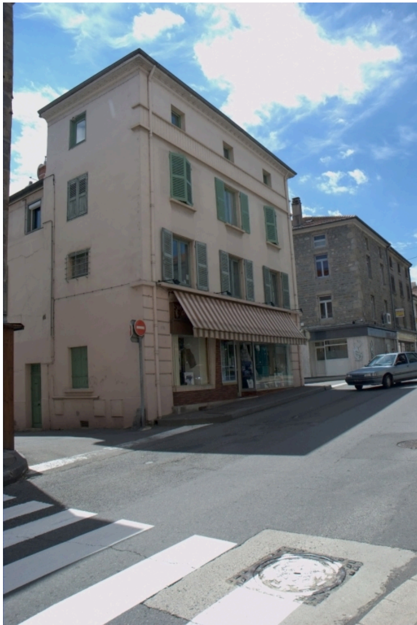
Îlot 7. République (place de la) 08, 10 / Clermont (rue de) 64 / Carnot (place). Vue générale des façades sur la rue et la place carnot.
