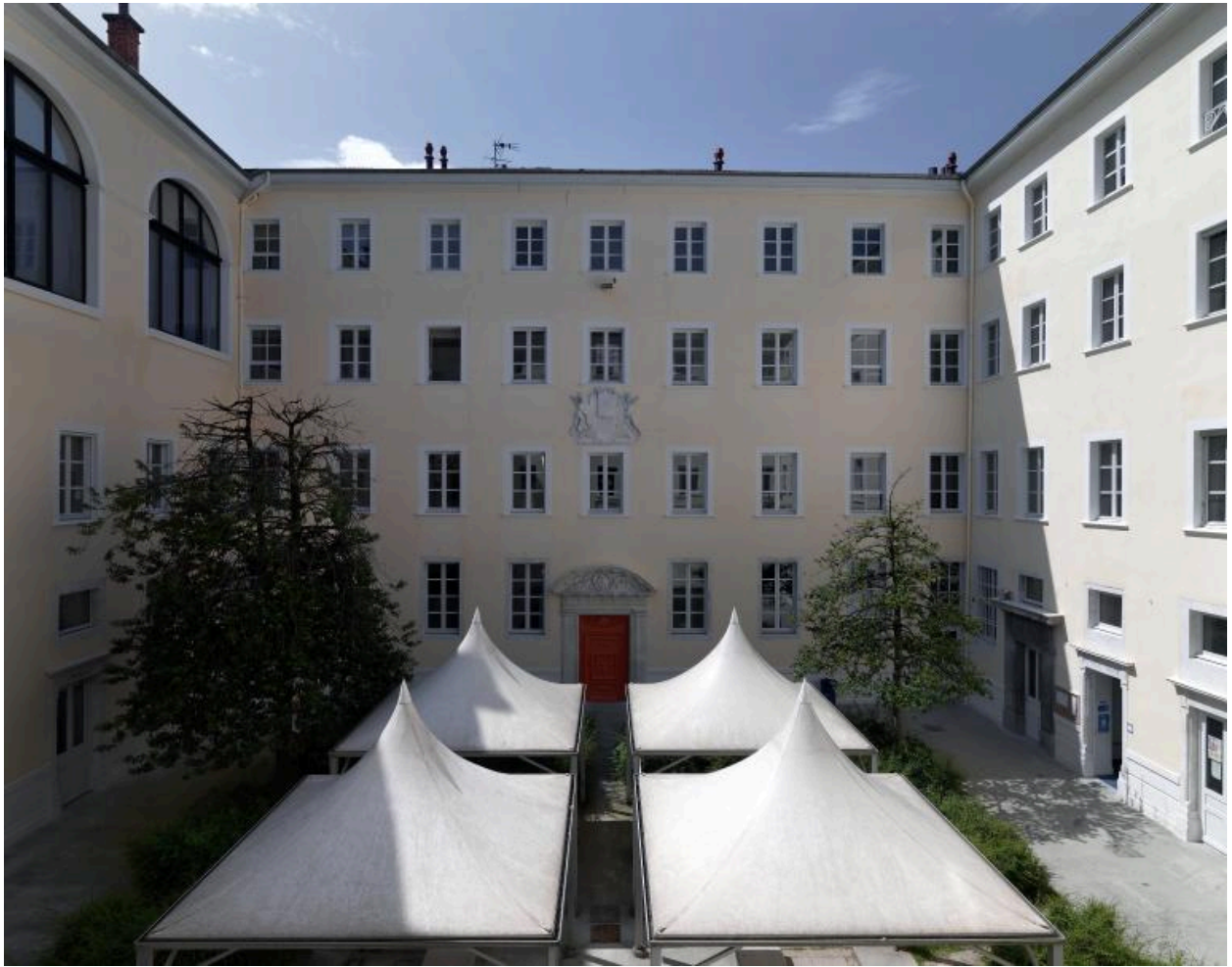
Cour d'honneur, vue d'ensemble depuis le nord
